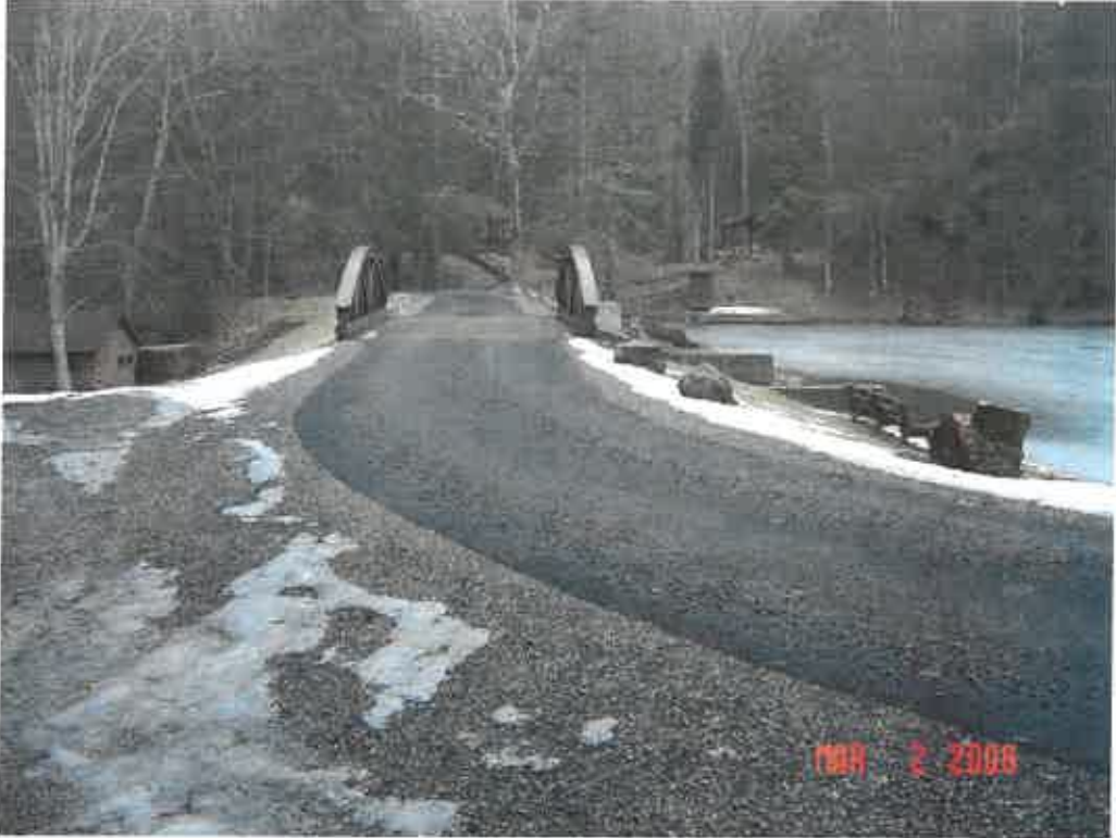
SENECA DAM MODIFICATION, POCAHONTAS CO., WV
